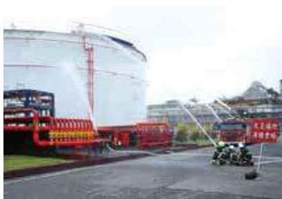
消防組架起水線灑水
